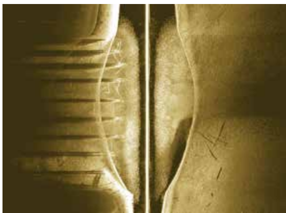
1 pav. Sonarinėje nuotraukoje (dešinėje) fiksuotos vertikalios ir horizontalios medinės senojo tilto konstrukcijos Dubingių tilto ŠR dalyje (kairėje – dabartinio tilto poliai). R. Kraniausko nuotr.
